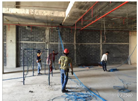
รูปที่ 2 การร้อยสายสัญญาณคอมพิวเตอร์ภายในอาคาร
